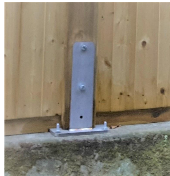
Poteaux SonoPost, pose sur platines inox 10mm avec base de 20x20cm.
